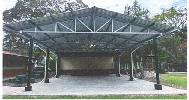
Foto 2: Ampliación de cubierta de lámina.
