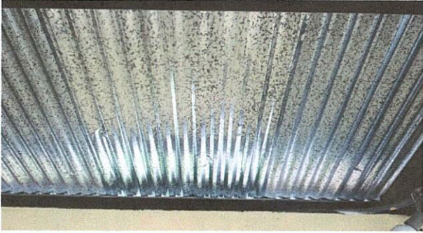
Foto1: Mejoramiento de techo por deterioro
