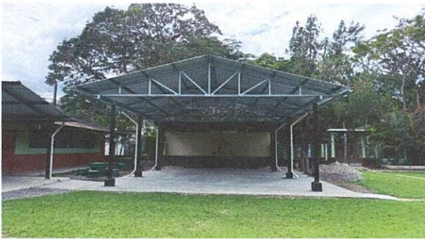
Foto 3: Ampliación de estructura Metálica .
